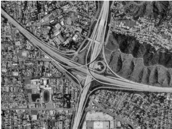
Abb. 47 Luftaufnahme des Autobahnkreuzes
