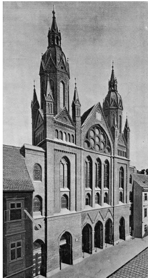
Abb. 4.53: historisches Foto der Westfassade
