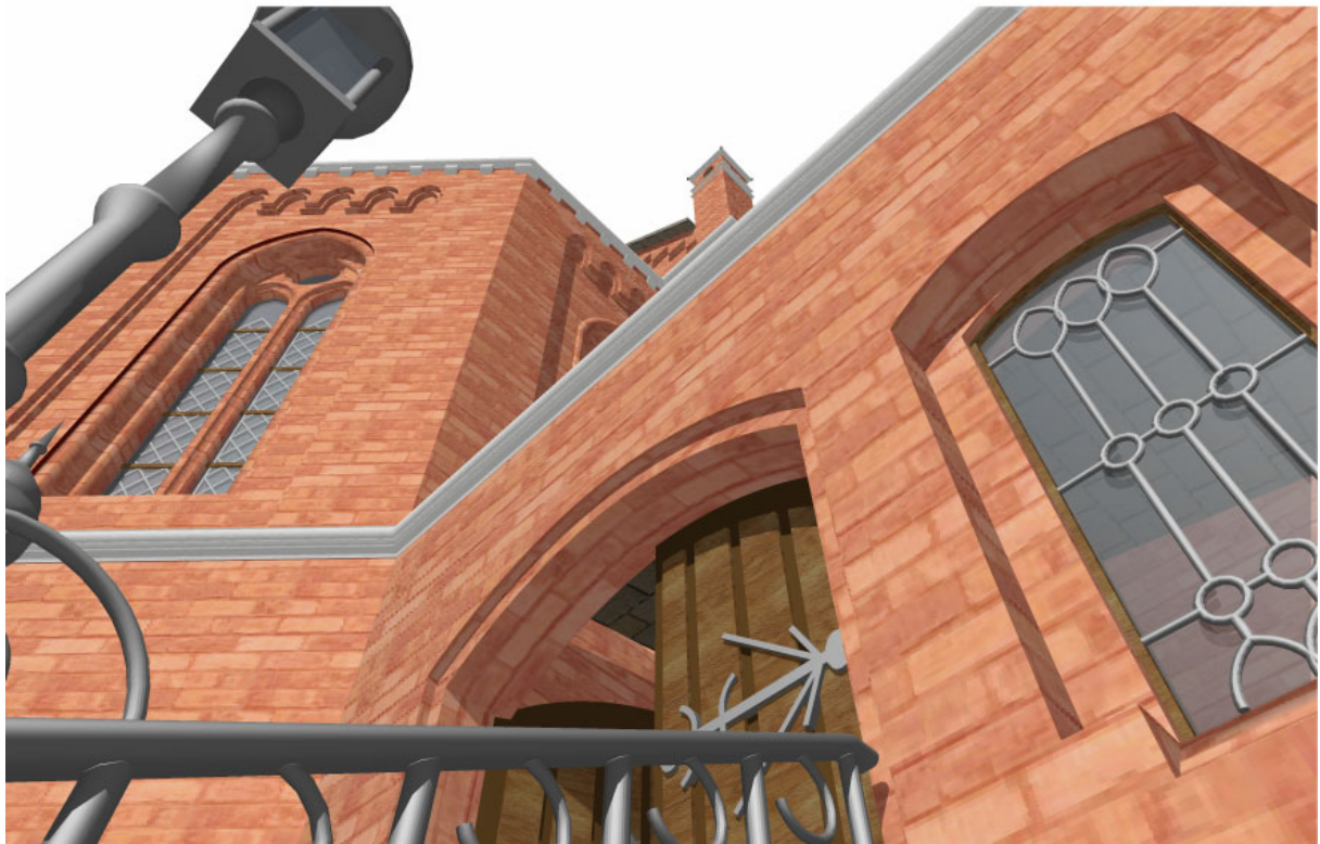
Abb. 4.38: Detail des östlichen Eingangs
