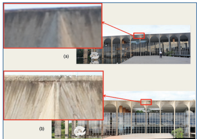
Figura 1: Comparação entre duas imagens do Palácio Itamaraty, Brasília, DF: (a) Imagem regular (comum) e, (b) Imagem panorâmica gerada pela plataforma robótica. Fonte: Cordoba (2012) e Christakou (2012). (Costa-MS-01.jpg)
