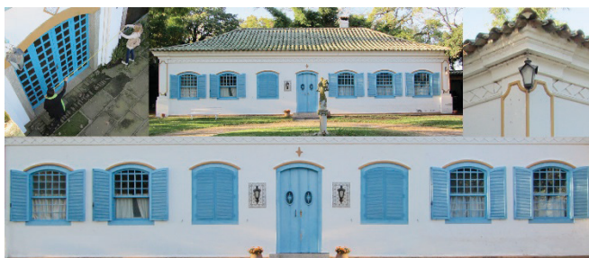
Figura 2: Acima e à esquerda, medições externas da charqueada Santa Rita; Ao centro, fotografia para obtenção de textura (Ortofoto); À direita, fotografia em perspectiva para compreensão dos detalhes da edificação. Abaixo, fotografia editada para textura da fachada principal. Fonte: Autores, 2012.
