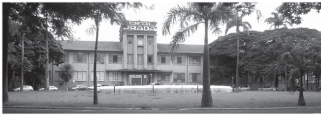
Figura 2: Fachada principal do Edifício Prada. Foto: Rafaela do Amarante Carneiro, 2013.
