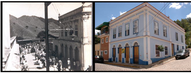
Fig. 2 Comparação de imagem do prédio da Rua Capitão José Inácio, 91 com fotos da década de 20 e foto atual (2008)
