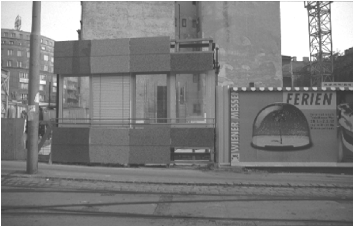
Abb. 14 1:1-Proben mit der Bemusterung auf der Baustelle.
