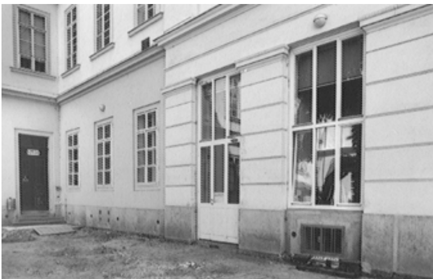
Abb. 52 Hofseitiger Eingang des Raumexperimentierlabors.
